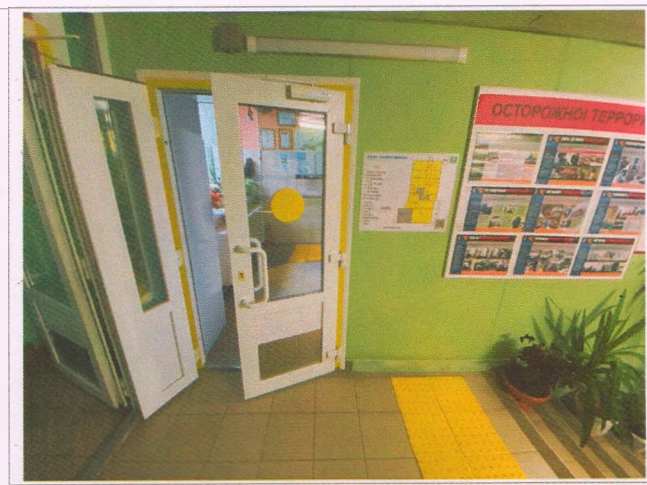
Фото № 12 – Пути движения внутри здания. (двери) Мнемосхема (расположены на каждом этаже учреждения).
