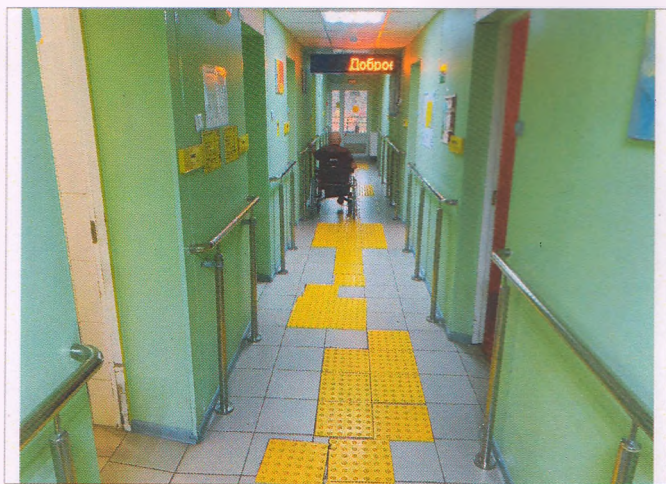
Фото № 13 – Пути движения внутри здания. Опорные поручни. Тактильные напольные указатели. Электронное табло (бегущая строка)
