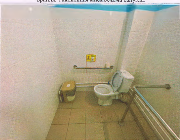
Фото № 36– Санитарно-гигиеническое помещение. Поручни, кнопка вызова помощи со шнурком.
