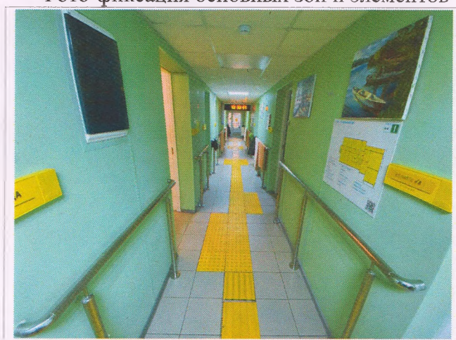
Фото № 14 – Пути движения внутри здания. Опорные поручни. Тактильные напольные указатели. Электронное табло (бегущая строка)
