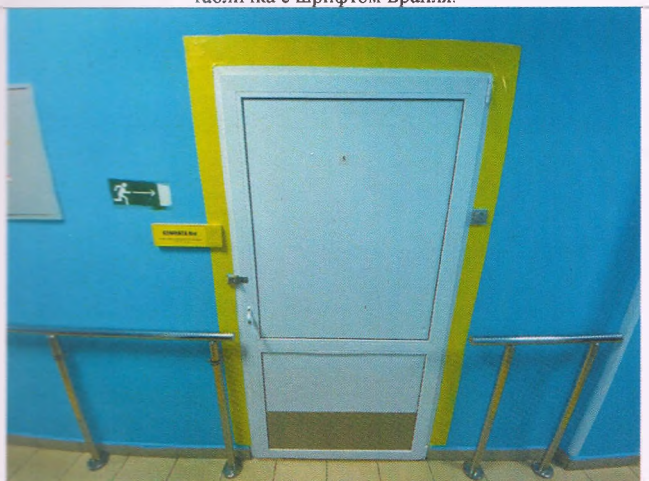
Фото №23– Пути движения внутри здания (двери в жилые комнаты). Информационная тактильная-звуковая табличка с шрифтом Брайля.
