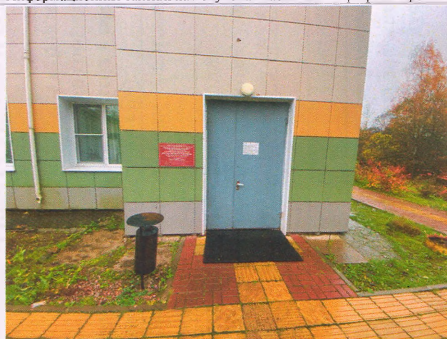
Фото № 54 – Запасной выход. Прилегающая территория. Тактильные наземные указатели
