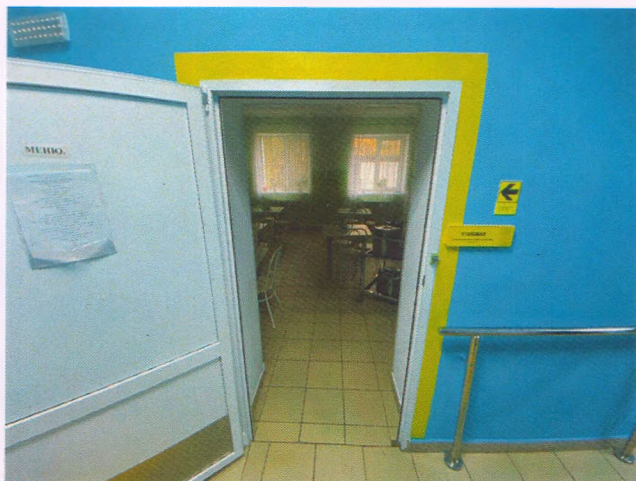
Фото № 27 — Пути движения внутри здания (двери). Информационная тактильная-звуковая табличка с шрифтом Брайля. Зал столовой.
