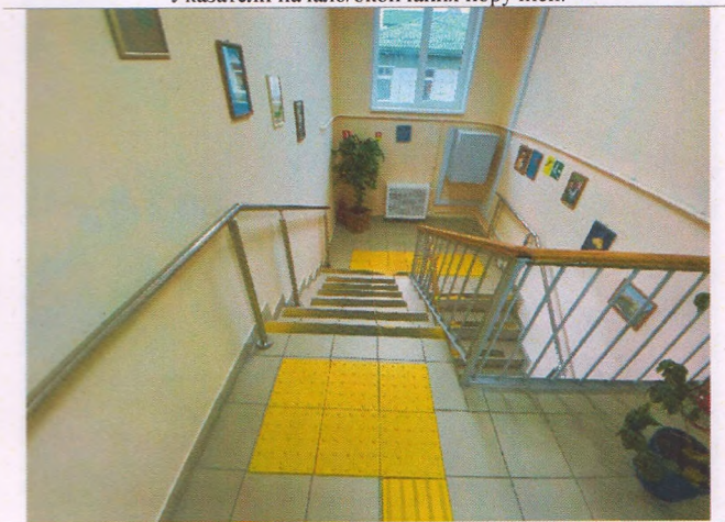
Фото № 17 – Пути движения внутри здания (лестницы). Тактильные напольные указатели.
