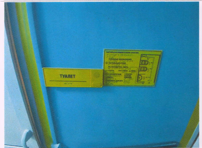
Фото № 46– Информационная тактильная-звуковая табличка с шрифтом Брайля. Тактильная мнемосхема санузла.
