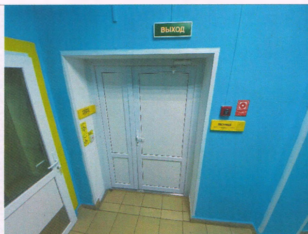
Фото № 52– Информация на объекте. Пиктограммы с шрифтом Брайля. Информационная тактильная-звуковая табличка с шрифтом Брайля.
