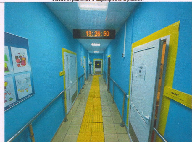
Фото №47 – Информация на объекте. Опорные поручни. Тактильные напольные указатели. Электронное табло (бегущая строка)
