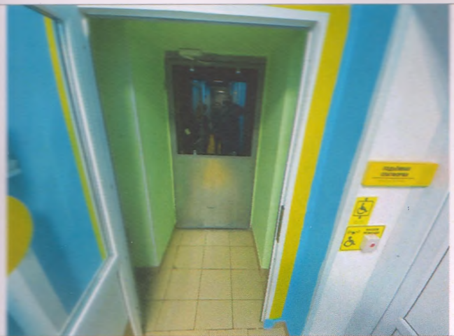
Фото №19 – Подъемная платформа. Информационная тактильная-звуковая табличка с шрифтом Брайля. Пиктограммы.
