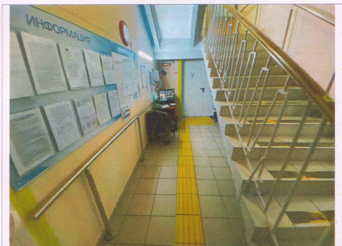
Фото № 11 – Пути движения внутри здания. Тактильные напольные указатели.
