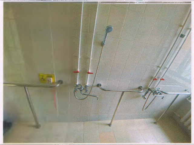
Фото №40 – Санитарно-гигиеническое помещение (душ) Поручни, кнопка вызова помощи со шнурком.
